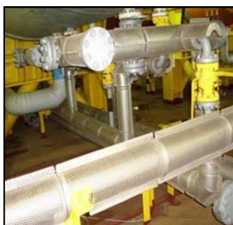
ЗАЩИТНОЕ ПОКРЫТИЕ ТРУБ
